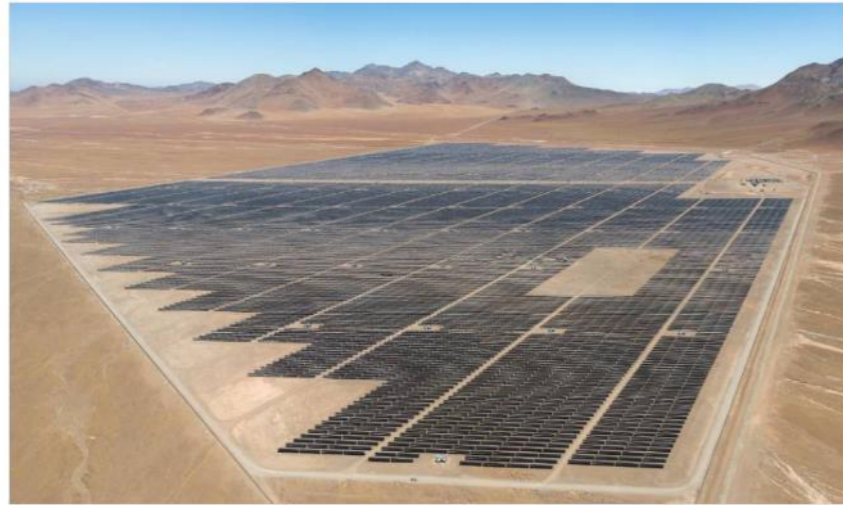
Central Fotovoltaica de First Solar en Chile ofrecerá servicios complementarios a la red eléctrica de forma automatizada
